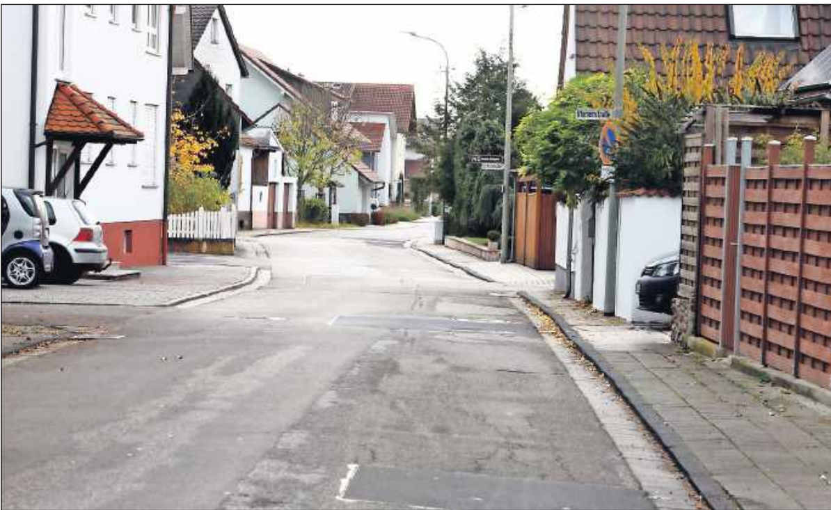
Schluss mit der Flickschusterei: In Neuburg werden etliche Straßen jetzt saniert.
