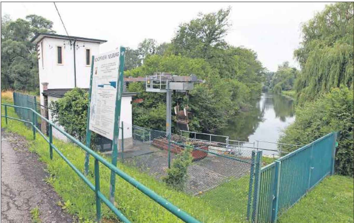
Das Neuburger Schöpfwerk könnte in Zukunft ganzjährig schon ab 4,50 Metern pumpen.
