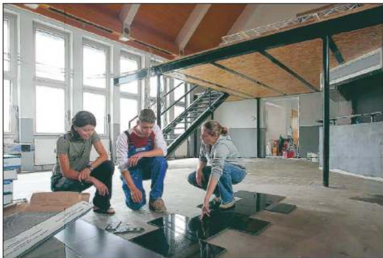
Welche Fliesen kommen in das neue Jugendzentrum? Jasmin Westerman, Dominic Pfirmann und Julia Westermann sind mit Feuereifer bei der Arbeit.
